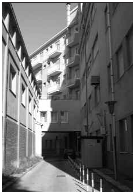
Uno scorcio dell'Ospedale visto dal Pronto Soccorso. Di fronte le pensiline dei balconi rinnovate
