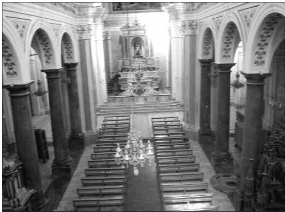
Nella foto la Chiesa di S. Angelo nello stato in cui trovasi oggi, ripulita e con i banchi sistemati. Si stanno ultimando i lavori dell'impianto elettrico e del montaggio del pozzo
