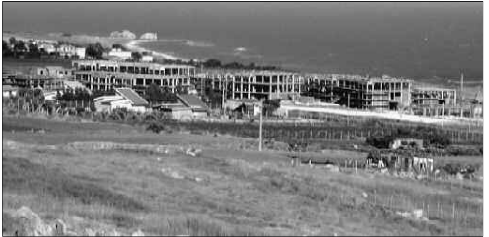
Il villaggio turistico in costruzione. Sullo sfondo le Due Rocche
