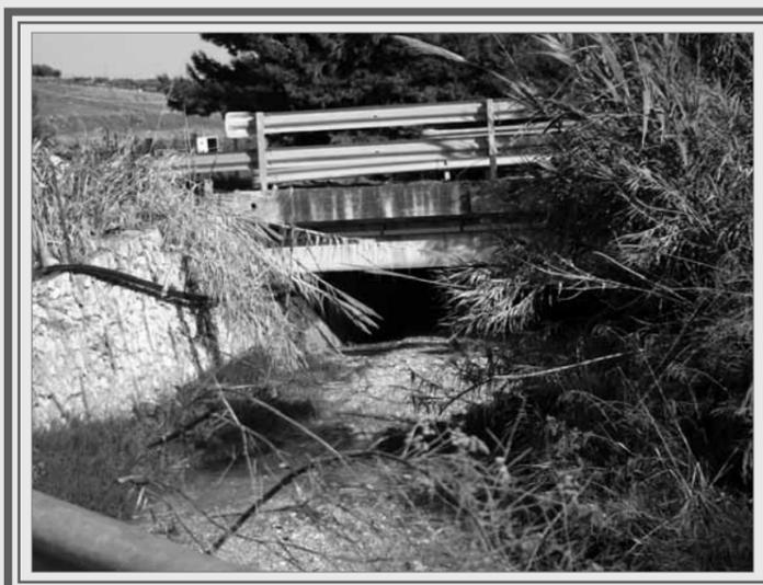
della sezione idraulica in corrispondenza della luce del ponte sulla S.S. 115 al km. 136,900, dove la distanza tra il fondo del nuovo alveo formatosi a seguito di deposito di detriti pietrosi e la quota di sottotrave del ponte della stradale si è ridotta a mt. 1,20 circa e la presenza di vegetazione spontanea a causa della mancata manutenzione.
