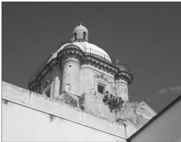
non era prevista nel progetto di restauro, ma le lesioni che si sono evidenziate e il distacco di una ringhiera attorno ad essa sono segni che ne compromettono la stabilità.
